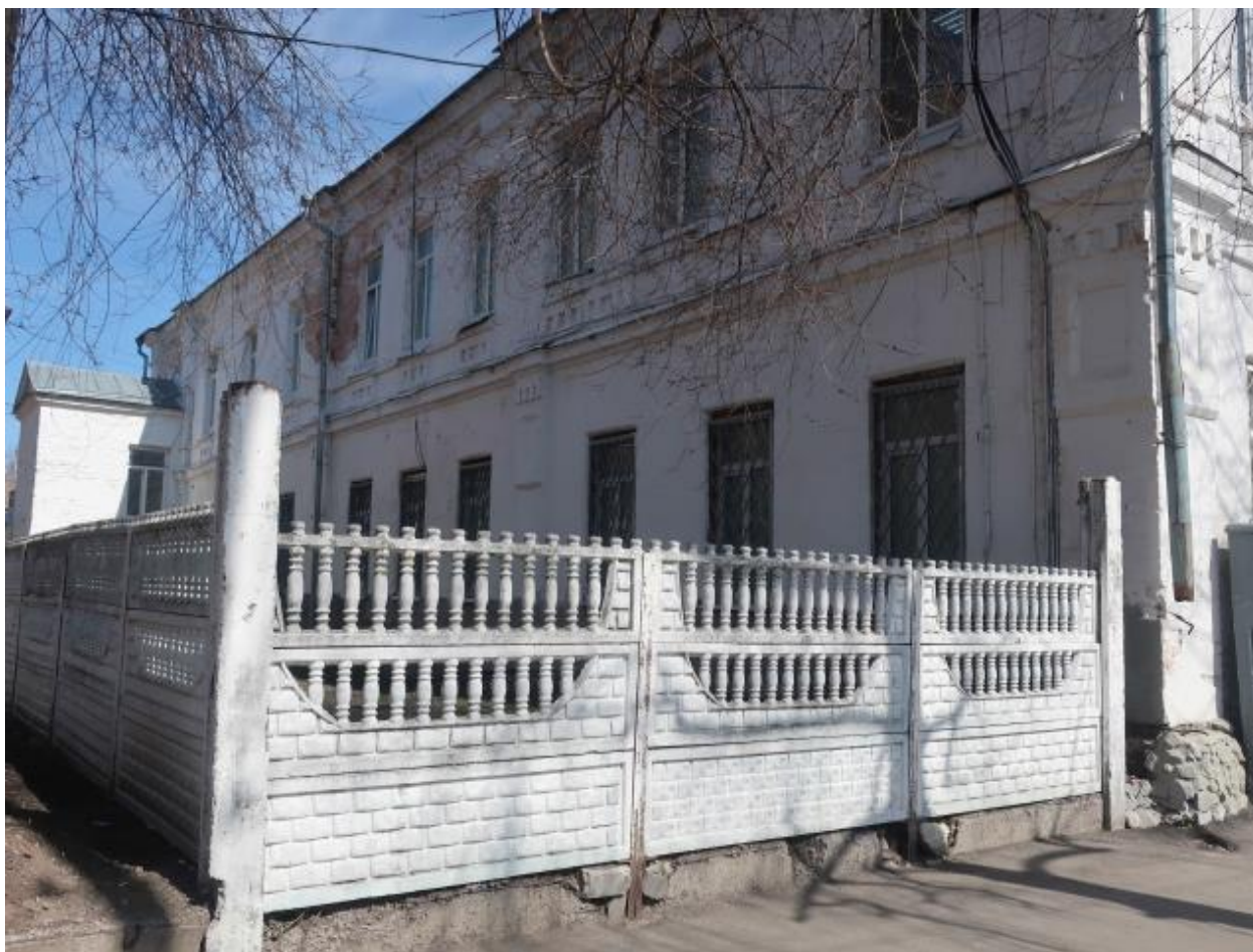
Точка фотофиксации 6. Западный (боковой) фасад со стороны юго-восточного угла дома №15 по ул. Тухачевского
