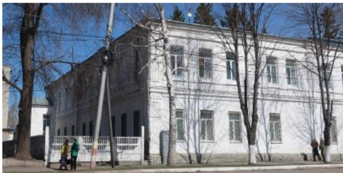
Точка фотофиксации 8. Юго-западный фасад со стороны ул. Тухачевского
