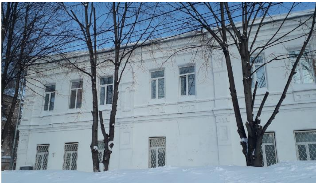
Точка фотофиксации 4. Южный фасад со стороны ул. Тухачевского
