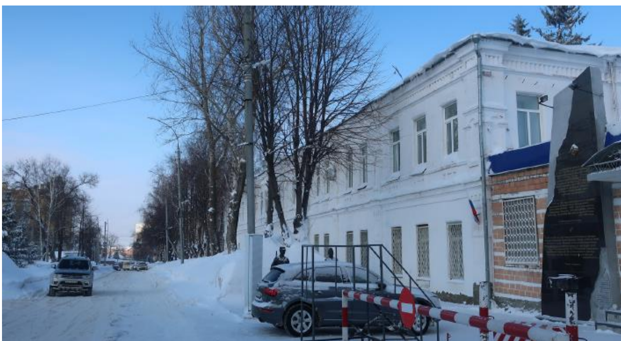
Точка фотофиксации 2. Южный фасад со стороны ул. Тухачевского
