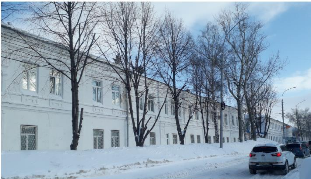
Точка фотофиксации 3. Южный фасад со стороны ул. Тухачевского
