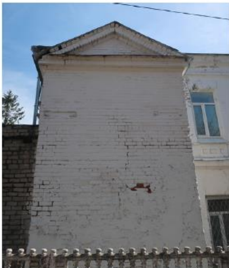
Точка фотофиксации 9. Пристрой к западному (боковому) фасаду со стороны восточного фасада дома №15 по ул. Тухачевского
