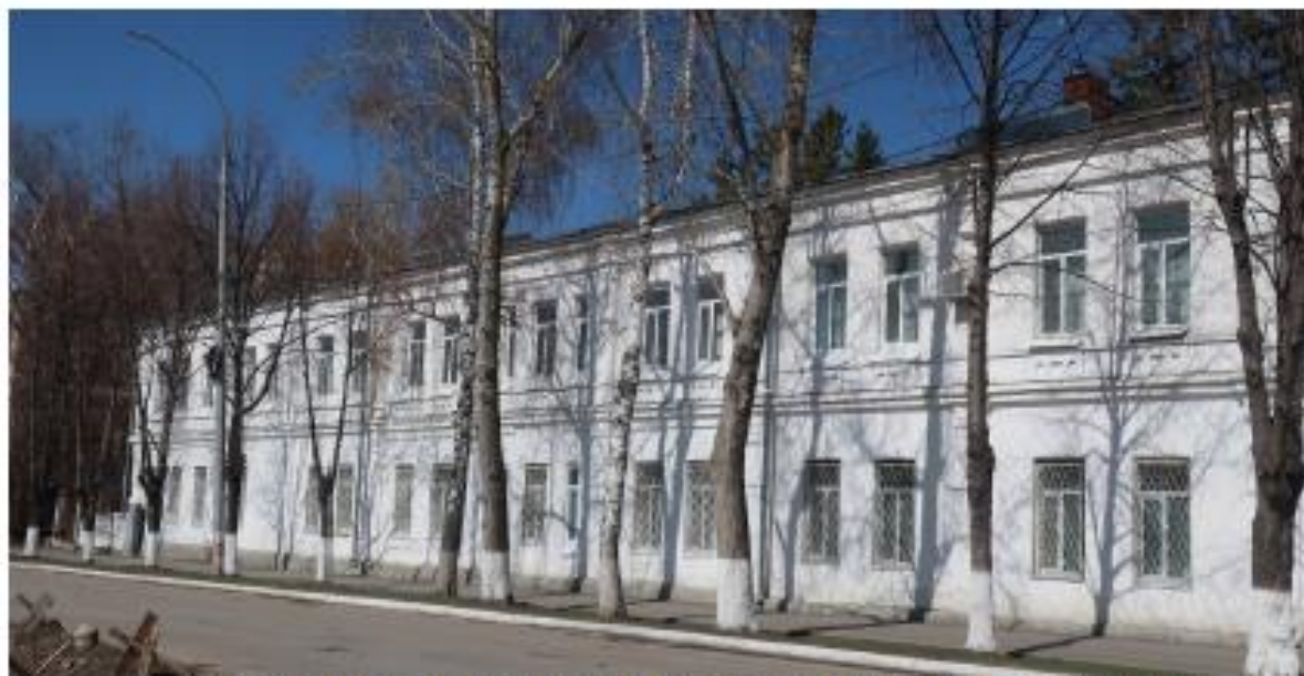
Точка фотофиксации 7. Южный фасад со стороны ул. Тухачевского
